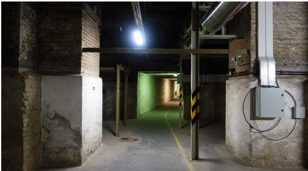
Abb. 2: Die unterirdischen Gewölbe dienten in ihren Anfängen als Belüftungssystem, zwischenzeitlich gab es eine Förderanlage für Bücher, Fotograf: Chris Herrmann, CC BY-SA 4.0, https://creativecommons.org/licenses/by-sa/4.0/deed.de
